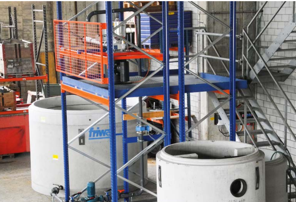
Modular aufgebaute Regenwasserbehandlungsanlage im Technikum Eichwies der HSR. Massstabgetreu lassen sich verschiedenste Anlagenkomponenten zusammenstellen und unter kontrollierten Bedingungen zur Leistungsbeurteilung testen
