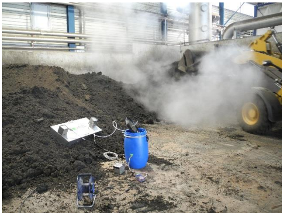
Geruchsprounabnahme auf einer Kläranlage
