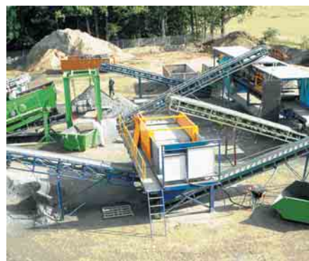
Anlage zur Schlackenaufbereitung
