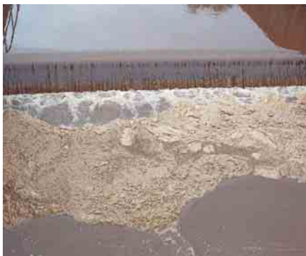
Wenig Schwimmschlamm in der biologischen Reinigungsstufe
