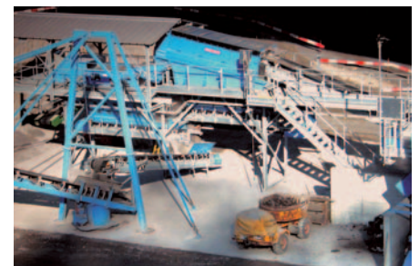
Stationäre Anlage zur Metallrückgewinnung in der Deponie Teuftal AG.
