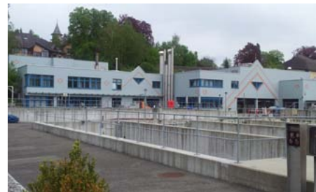
Auf der Kläranlage Flos in Wetzikon werden die Versuche durchgeführt. (Foto: ARA Wetzikon)
