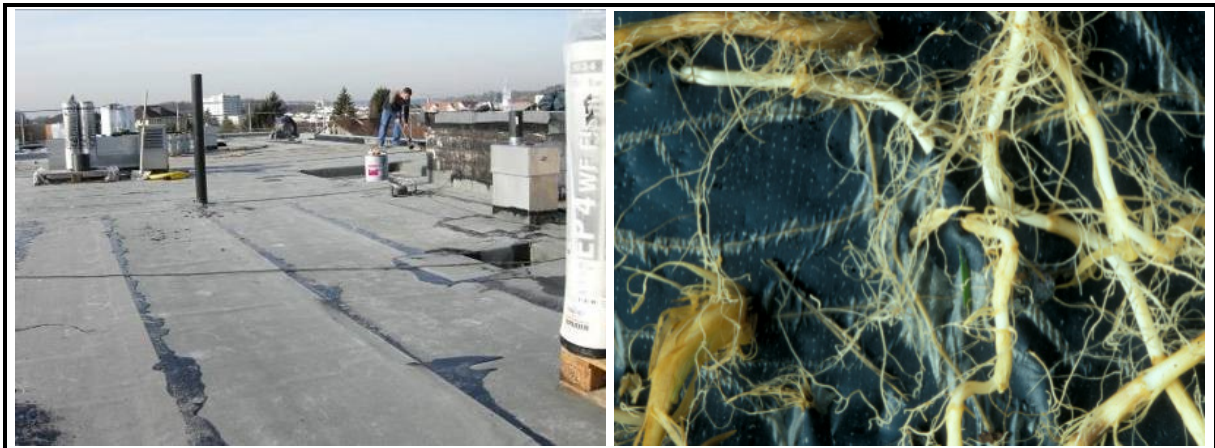
Abb. 6: Wurzelfeste Bitumenbahnen für Dachabdichtungen, vor allem bei begrünten Flachdächern.
