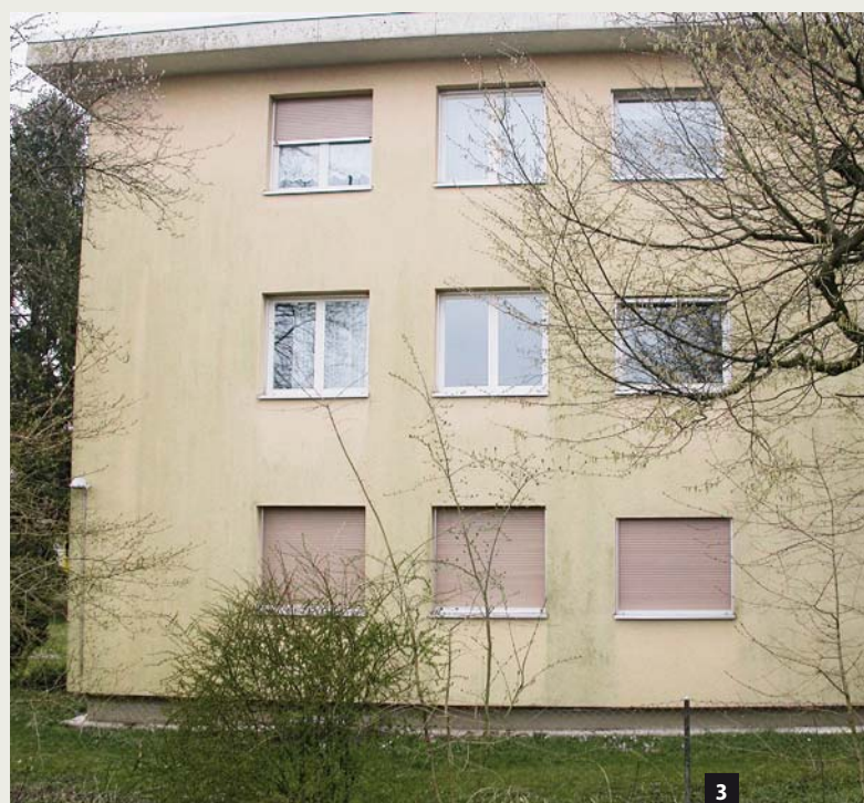
Abb. 2 und 3: Bewitterte Westfassade, die durch dichten Bewuchs kaum abtrocknen kann und stark befallen ist, und am gleichen Gebäude die Ostfassade, welche keine optischen Beeinträchtigungen aufweist.
