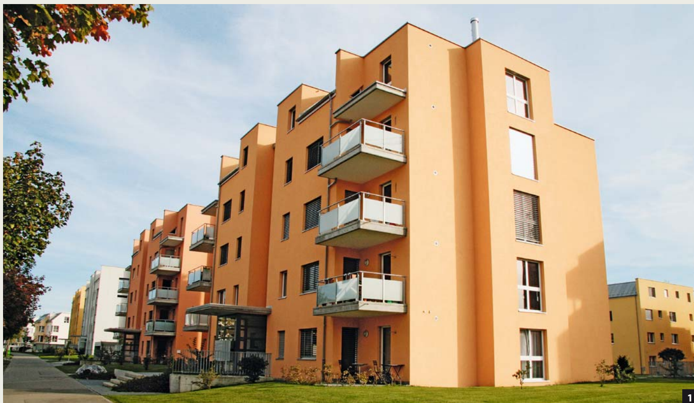
Abb. 1: Moderne Kompaktfassade, ausgerüstet mit Bioziden und wasserabweisend, die dem Regen aufgrund des fehlenden Dachvorsprungs voll ausgesetzt ist.
