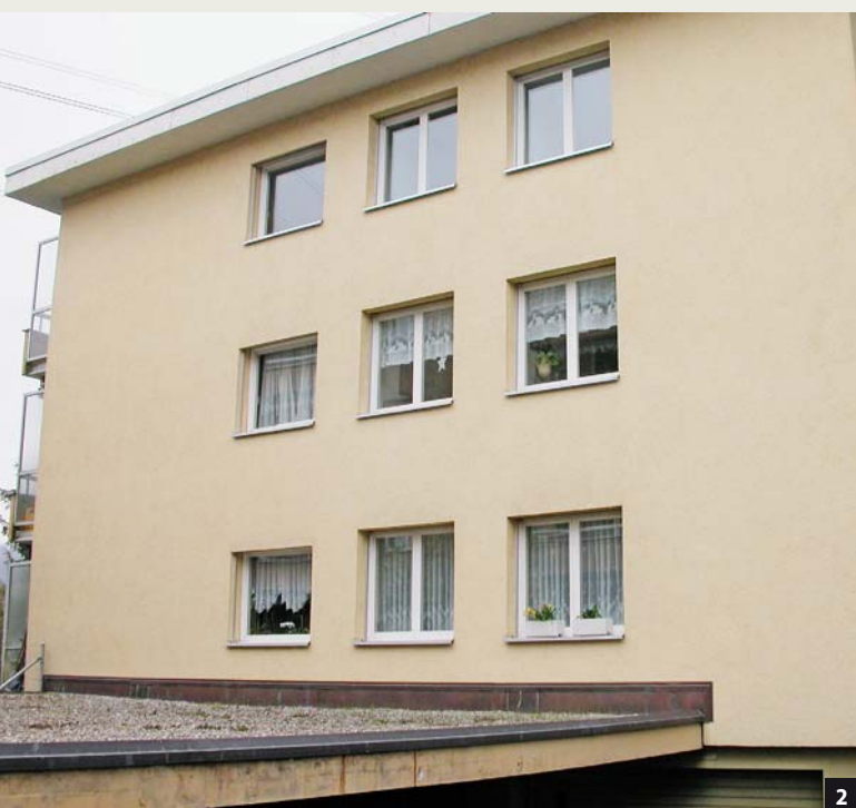
Abb. 2 und 3: Bewitterte Westfassade, die durch dichten Bewuchs kaum abtrocknen kann und stark befallen ist, und am gleichen Gebäude die Ostfassade, welche keine optischen Beeinträchtigungen aufweist.
