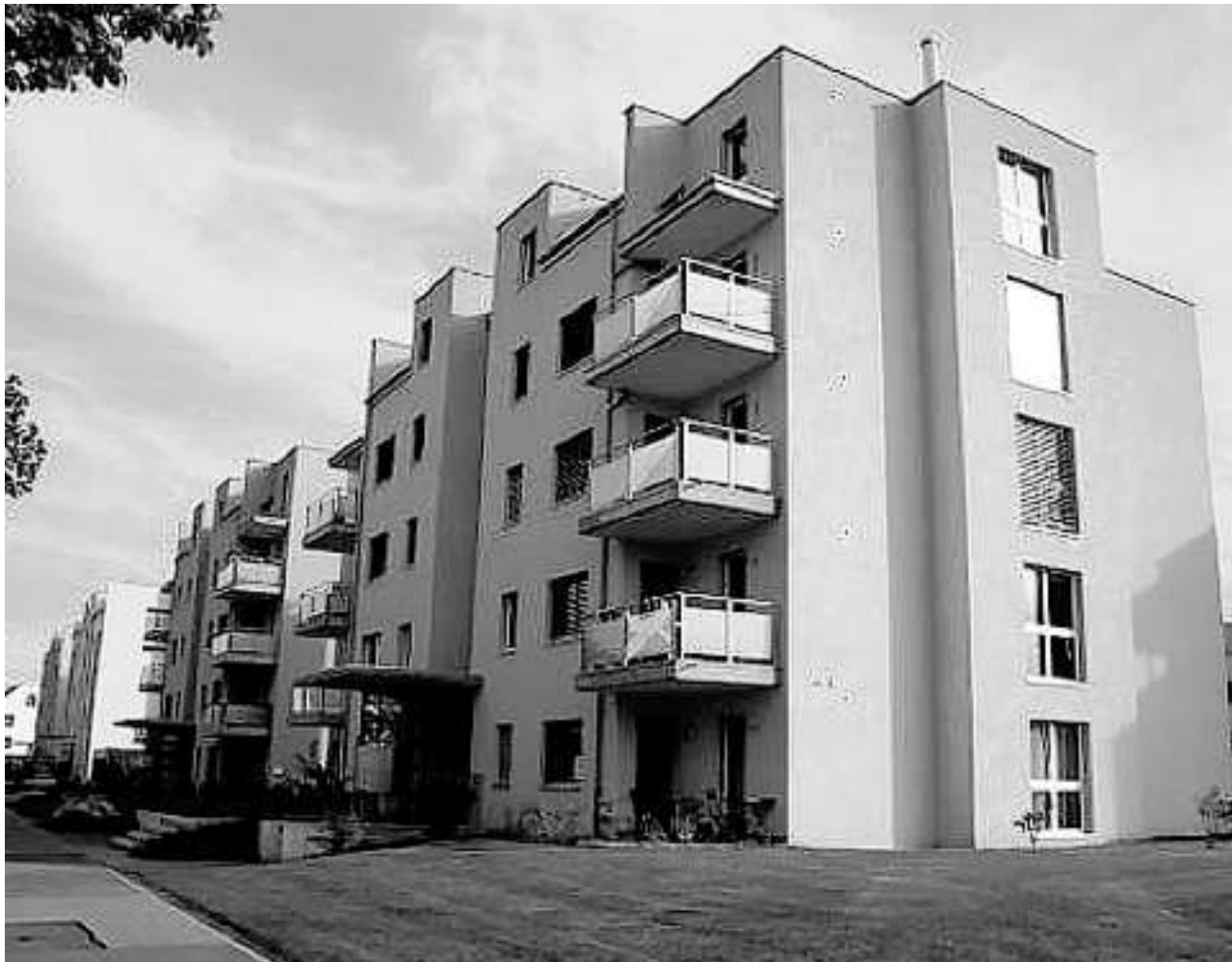
Gefährliche Farben: Mit dem Regen gelangen Biozide von Gebäude-Fassaden ungefiltert ins Wasser.
