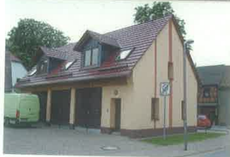
Ein ehemaliges Feuerwehrhaus im Norden Erfurts vor und nach der Fassadensanierung mit Wärmedämmung
