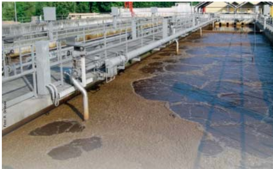
Aluminiumhaltige Flockungsmittel nützen gegen Blähschlamm.
