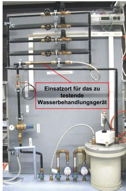
Abbildung 1: Teststrecke für Wasserbehandlungsanlagen; hier mit Rotgussrohr anstelle eines Testgerätes
